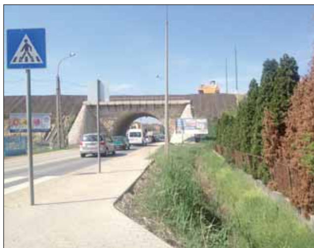
3. kép: A balatoni úti felüljáró építés alatt
