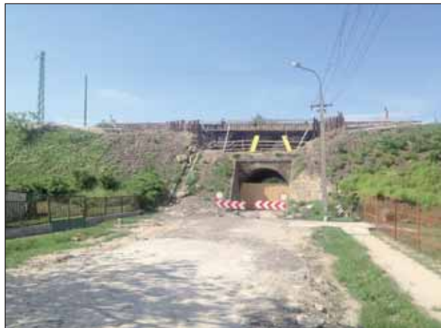
2. kép: Duna utcai tunel átépítés alatt
