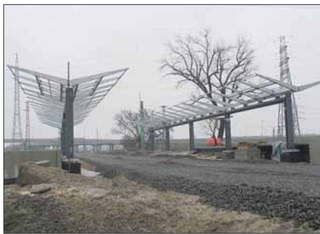
1. kép: Tétényliget vasúti megálló, háttérben a felüljáróval
